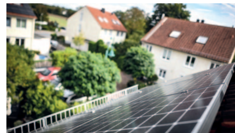
Da die Nachfrage nach Photovoltaikanlagen mit steigenden Energiekosten rasant wächst, bewerten die Stadtwerke Duisburg die Potenziale von Immobilien, um Solaranlagen zu planen und zu realisieren. (Foto: Stadtwerke Duisburg)
