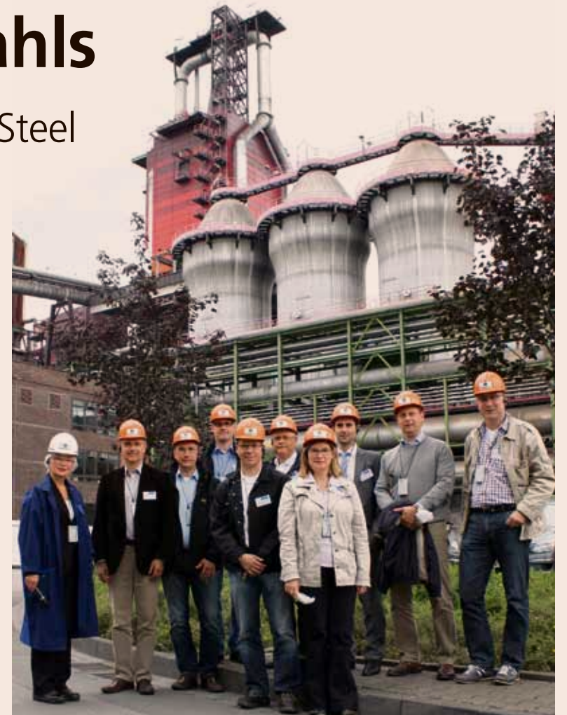
Markantes Bauwerk an der A 42: Die Unternehmer vor dem Hochofen 8 von ThyssenKrupp (Foto: Middelkamp)
